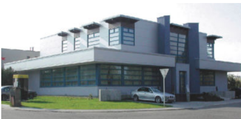
Obr.01 – Sídlo společnosti Barco, s.r.o.
